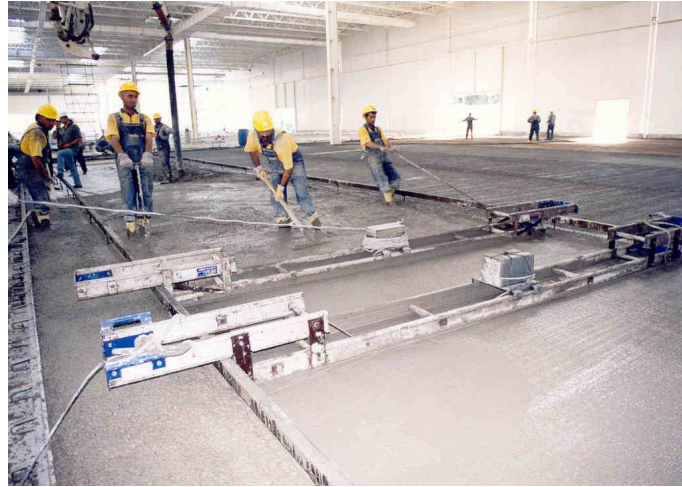
Şekil 5.1 Geçici master uygulaması
