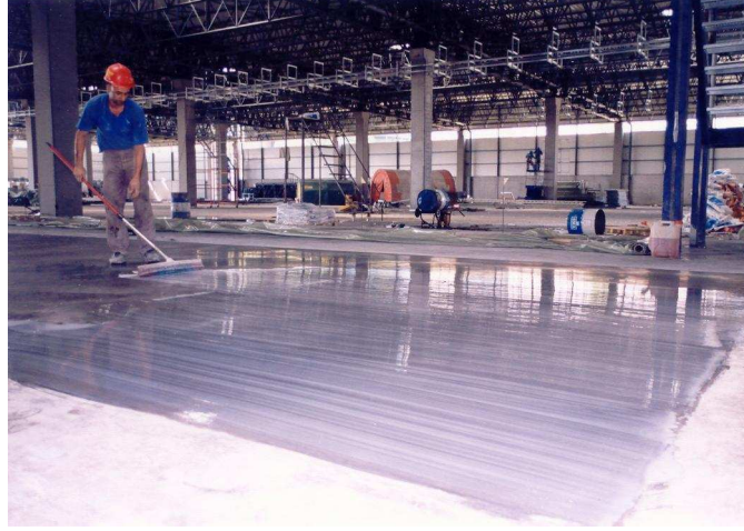
Şekil 4.24 Yüzeye parafin esaslı kür malzemesinin uygulanması
