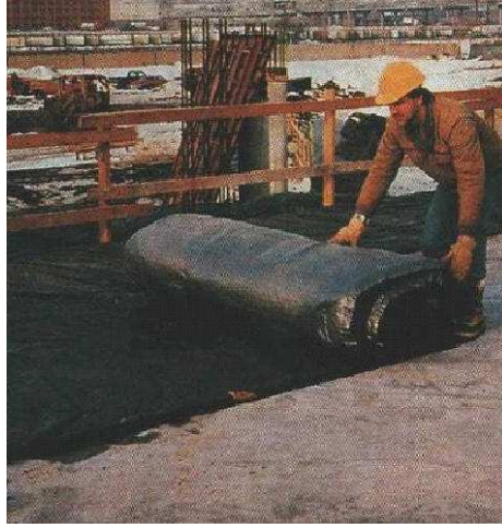
Şekil 4.23 Prizini tamamlamış betonun korunması
