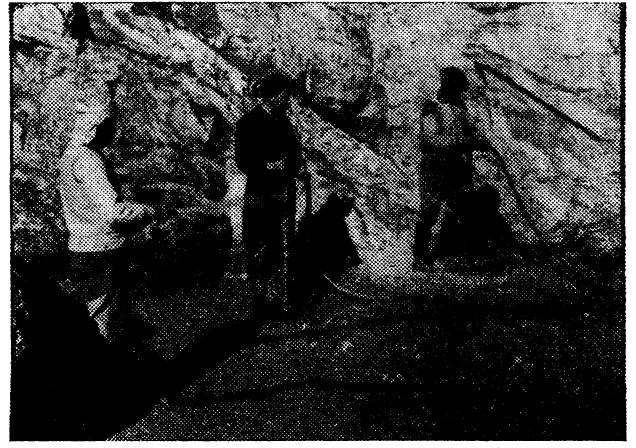
Şekil 10. — Su tankeri ve silindirlerin yanaşmadığı yamaç diplerinin elle sulanması ve havayla çalışan el tokmaklarıyla sıkıştırılması. (Demirköprü)
