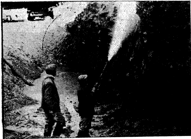
Şekil 9. — Temel hazırlanırken çamurlu kaya sathının basınçlı su - hava karışımı ile yıkanması. (Demirköprü)
