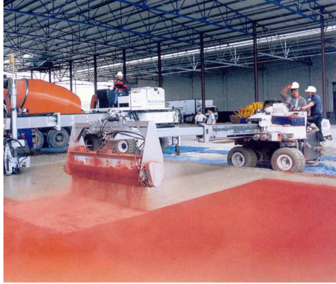
Şekil 5.8 Zemin beton yüzeye lazer kontrollü olarak yüzey sertleştirici uygulaması
