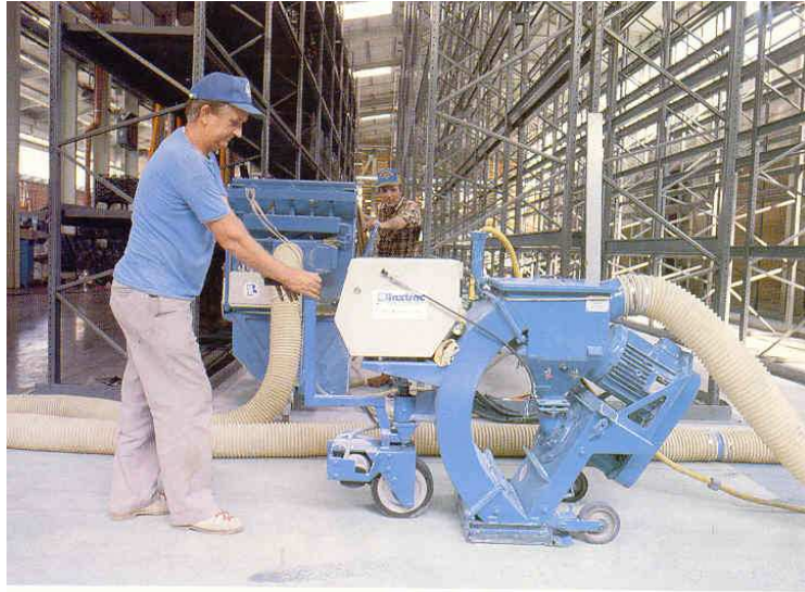
Şekil 5.11 Eski beton yüzeyinin temizlenmesi
