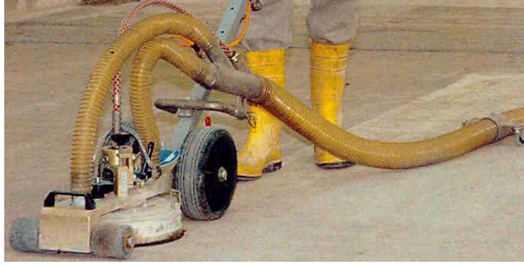
Şekil 5.12 Eski beton yüzeydeki kırıntıların su jetiyle uzaklaştırılması
