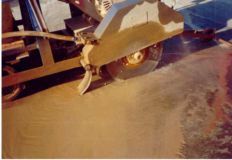
Şekil 6.19 Makina ile derz kesilmesi
