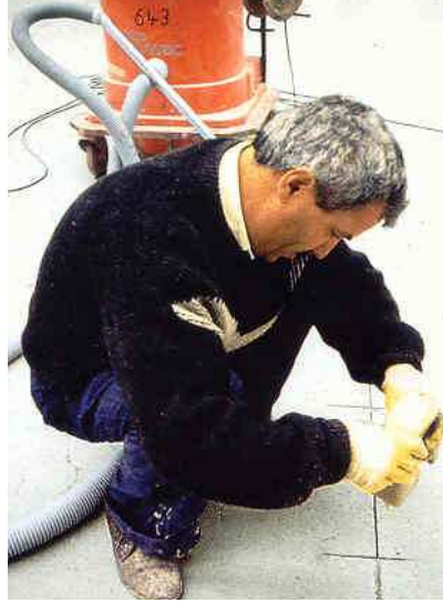
Şekil 6.21 Bir endüstriyel zemin betonunda açılan derzlerin doldurulmaları
