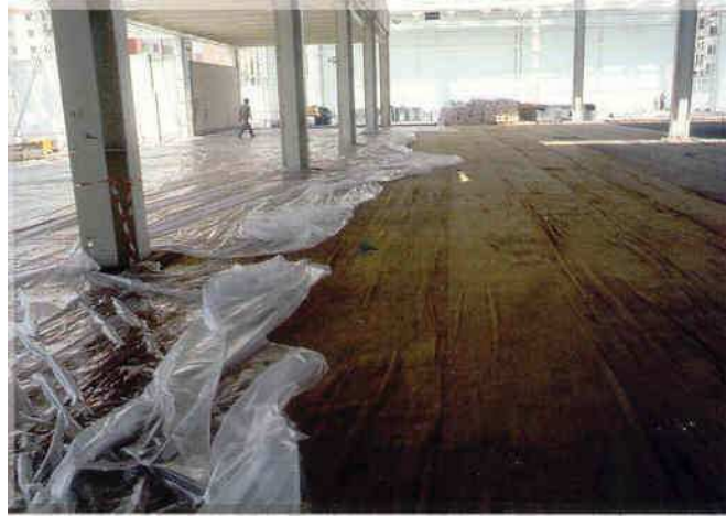
Şekil 6.6 Zemin betonunun yüzeyindeki rutubetin uzaklaşmasını önlemek için ıslak çuval üzerine naylon örtü serilmesi
