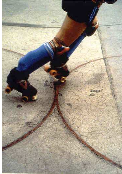
Şekil 6.7 Uygun olmayan düzeltme ve yetersiz kür nedeniyle oluşan ağ şeklinde çatlaklar
