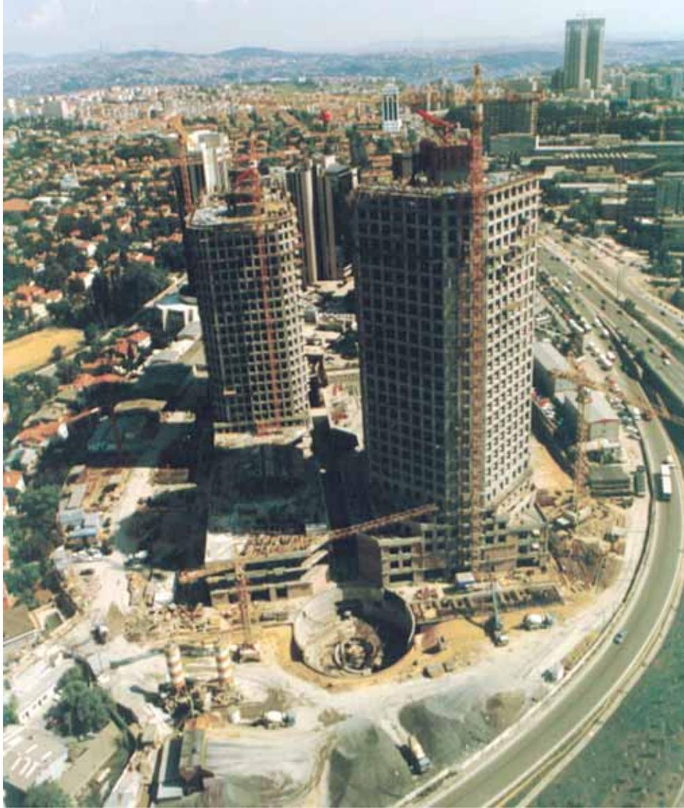
bölgede kalarak dayanabilecek biçimde inşa edilmiştir. Her üç kulenin en üst katlarındaki geri çekilmeleri sağlayan Vrendel kirişleri kritik olup, özel olarak projelendirilmiş ve imal edilmiştir. Kule-1'in en üst noktasındaki
