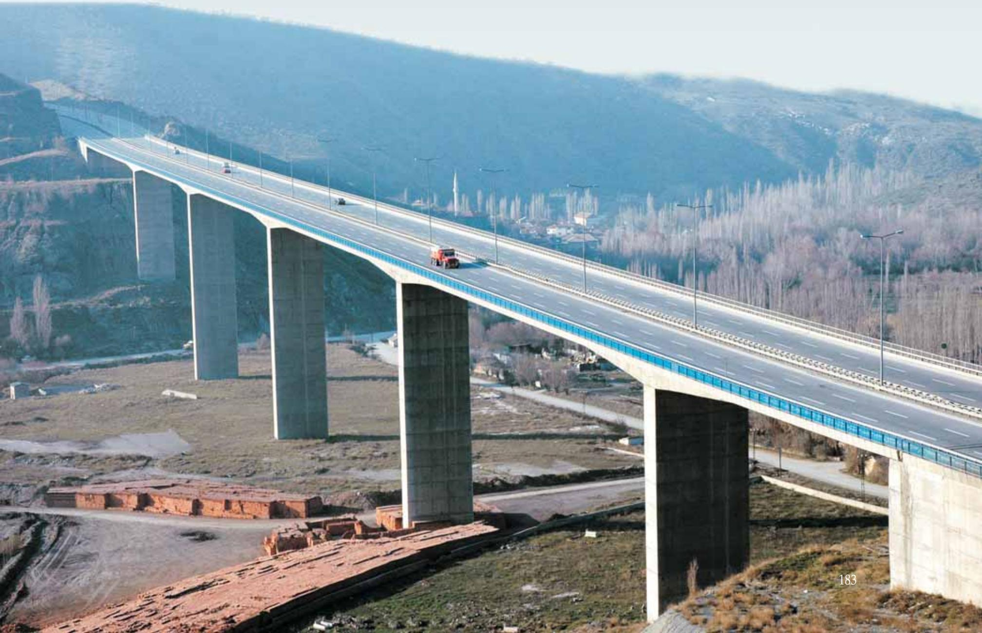
27 metre genişliğinde 3,60 metrelik dilimler halinde parça parça inşa edilen tabliye, yüksekliği köprü uzunluğu boyunca değişen bir kutu kesite sahiptir. Söz konusu kesitin içinde, beton dökümü sonrası gerilerek öngerilmeli kuvvetler yaratacak germe kablolarının geçişine izin veren yuvalar bırakılmıştır. Ayrıca, kesme kuvvetlerini almak, parazit çatlakları önlemek ve zamana bağlı deformasyonları kontrol altında tutmak üzere bol miktarda betonarme demiri kullanılmıştır.
