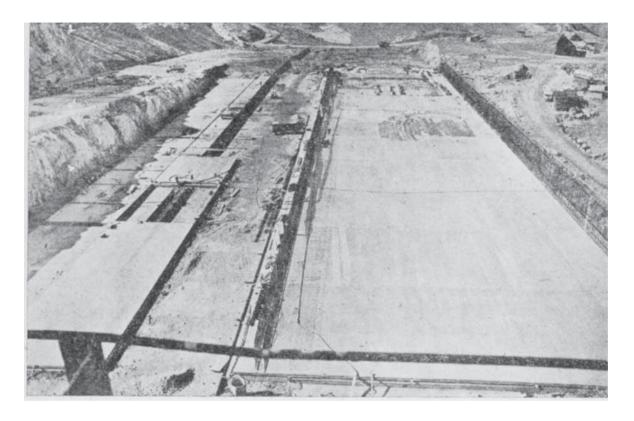
Temelden yüksekliği 210,86 metre ve toplam gövde hacmi 15,5 milyon m³ olan Keban Barajı 31 milyar m³ su toplanması temelinde tasarlanmıştır. İlk aşamada toplam 620,000 kW olan 4 ünite yapılmış, ikinci safhada ünite adedi 8'e, toplam gücü 1.240.000 kW'a çıkmıştır.
