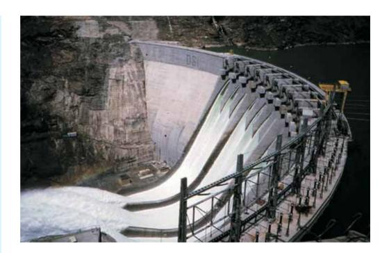
$2x1750 \text{ m}^3/\text{sn} = 3500 \text{ m}^3/\text{sn}$ , dipsavak kapasitesi ise  $708 \text{ m}^3/\text{sn}$  olarak planlanmıştır.
