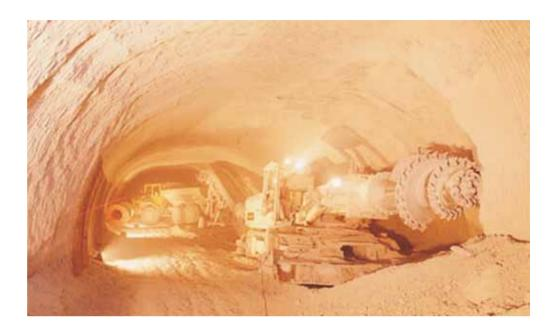
blentajlı konveyörü vardır. 1 400 kg/cm² basma dayanımına kadar sertlikteki kayaları kesme kapasitesine sahip makine minimum 2,6 metre yükseklik, 4,5 metre genişlik, maksimum 4,8 m. yükseklik ve 7,2 metre genişlik arasında değişen bir profili kesebilmektir. Birinci kademe kazısı 4,56 metre yükseklikte, 35 m² alanı olan yarım daire şeklinde, ikinci kademe kazısı 3,4 metre yükseklik 25 m² kesit alanlı, üçüncü kademe kazısı 1,16 m yükseklik ve 10 metre kesit alanına sahiptir.
