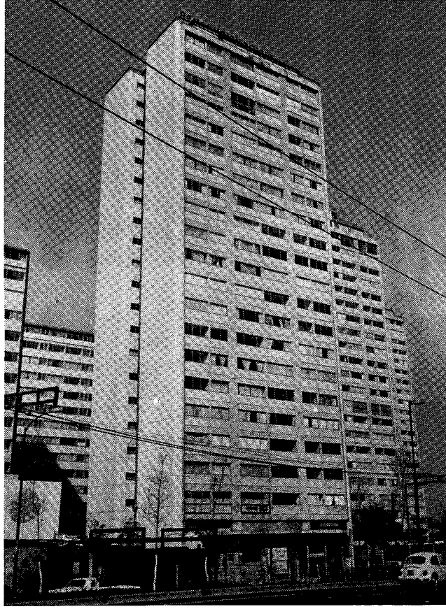
ŞEKİL 11. Meksike şehri Tlatalelco apartman sitesinde incelenen yapı
