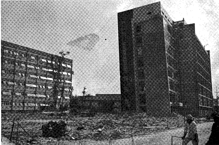
ŞEKİL 6. Bina temellerinde gözlenen kalıcı deformasyonlar
