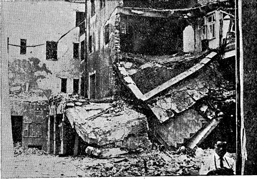
Foto. 10 — Tuğla binanın çöküşü. Üsküp İstasyon Binası.
