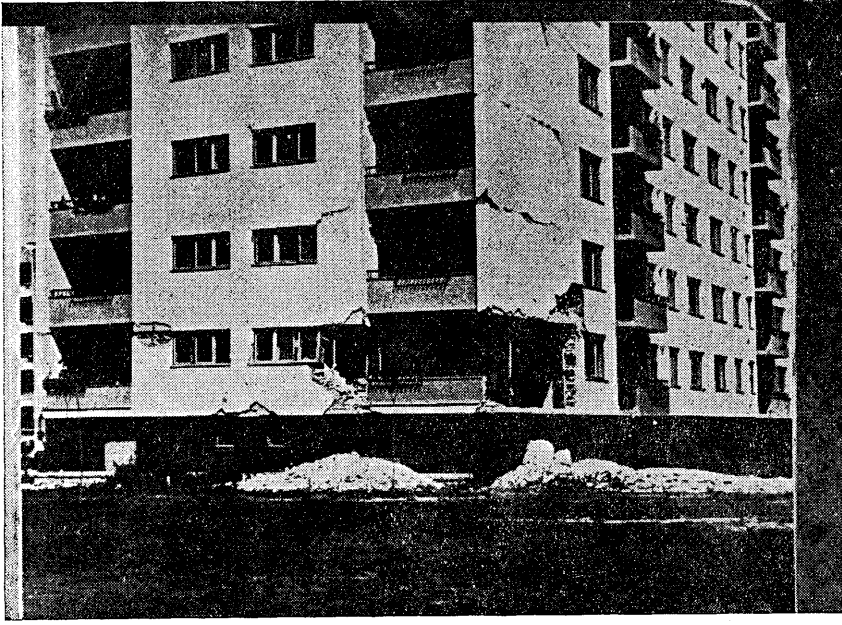
Foto. 25 — 14 katlı betonarme binada tuğla duvarların kırılması (Fotoğraf 23'e bakınız).
