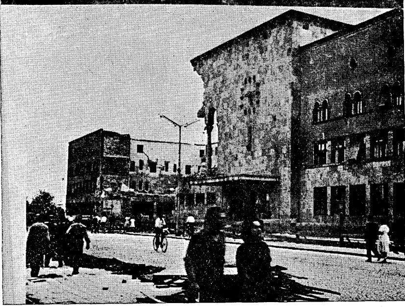
Foto. 9 — Tuğla binanın çöküşü. Üsküp İstasyon Binası.
