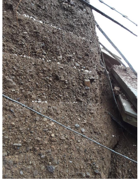
Şekil-8: Donatılı dolgu malzemesi içeriği
