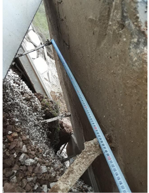
Şekil-6: Zemin donatı şeritleri yatay ve düşey aralıkları
