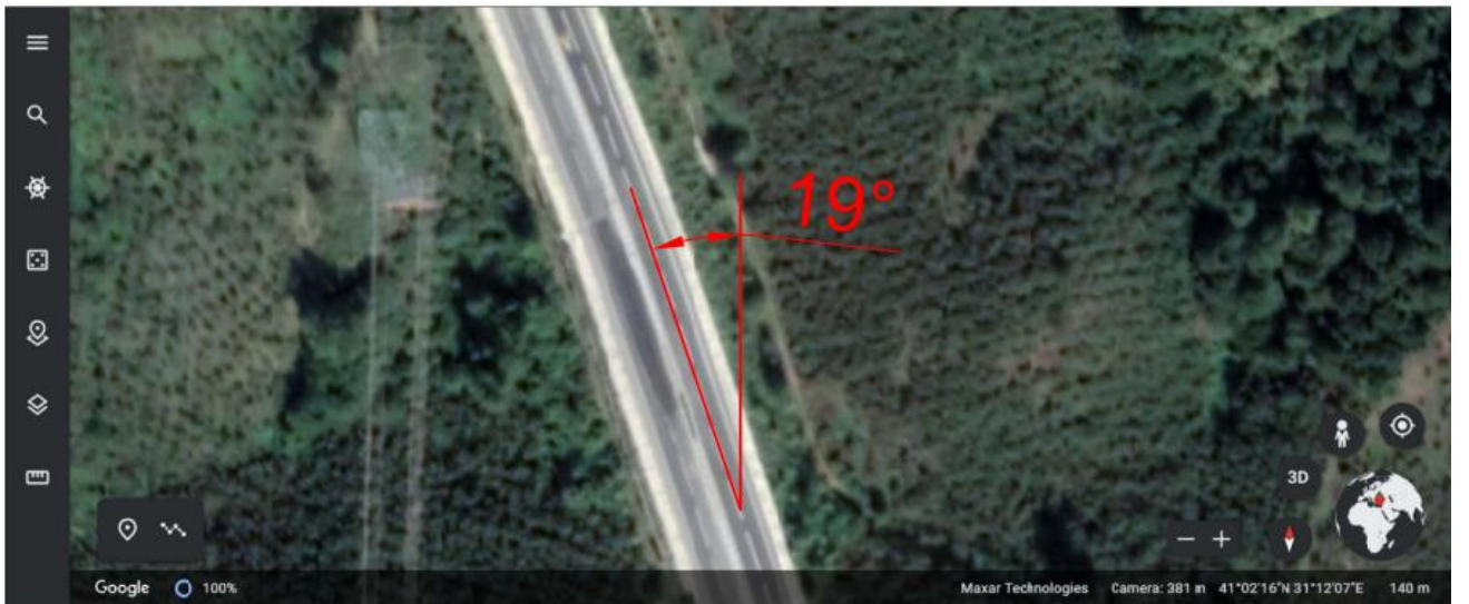
Şekil-1: Göçme öncesinde yolun durumu – Eylül 2020 (Kaynak: Google Earth)
