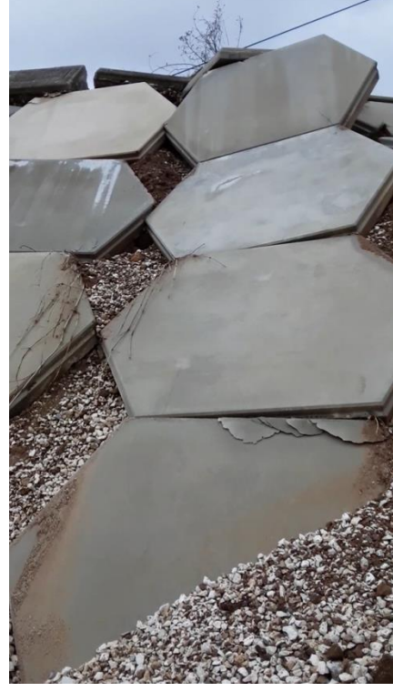
Şekil-7: Duvar cephe elemanı olarak kullanılan prekast betonarme altıgen paneller
