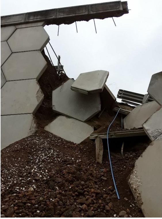
Şekil-7: Duvar cephe elemanı olarak kullanılan prekast betonarme altıgen paneller
