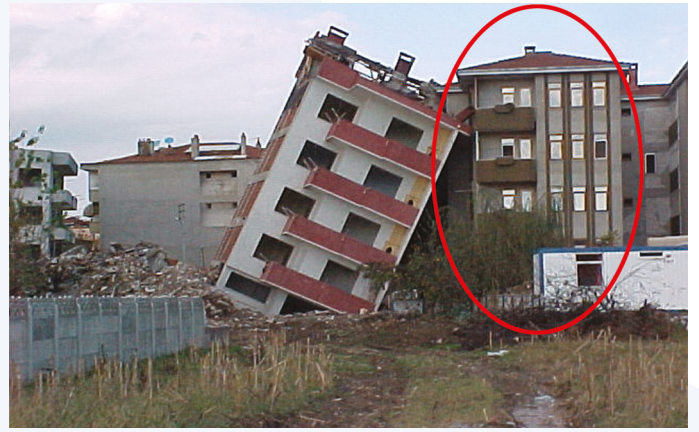
Zemin sıvılaşması sonucunda hasar görmüş yapılar.
