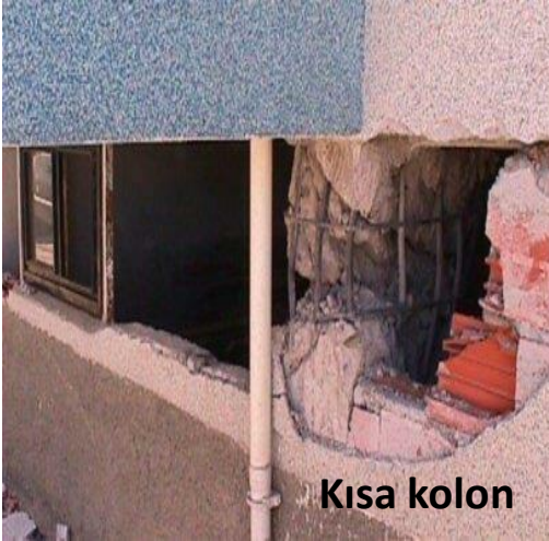
Kolonların hiç (çalışmadığı) katkı vermediği hasar
