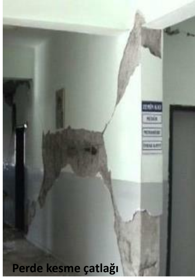
Kolonların hiç (çalışmadığı) katkı vermediği hasar
