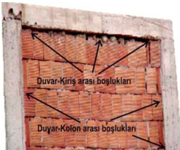
Şekil 9 - Dolgu Duvar-Kiriş-Kolon Ara Yüzeyi Milimetrik Boşluk Etkisi
