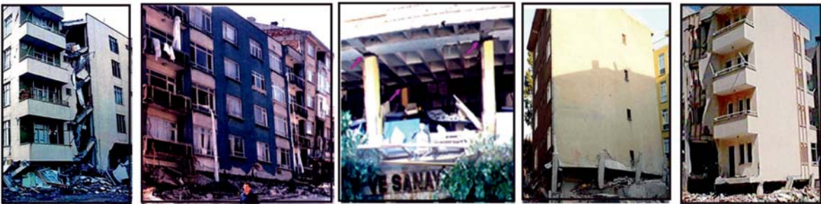
Şekil 15 - Duvarların Hesaba Katılmayışı Sonucunda Deprem Enerjisinin Duvarsız Katlarda Yoğunlaşması Sonucu Oluşan Göçmeler
