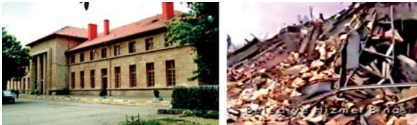
(a) 1939 ve 1992 depremlerini hasar almadan sağlamış olan Erzincan Gar Binası, (b) 1992 depreminde yerle bir olan Erzincan Belediyesi Hizmet Binası
