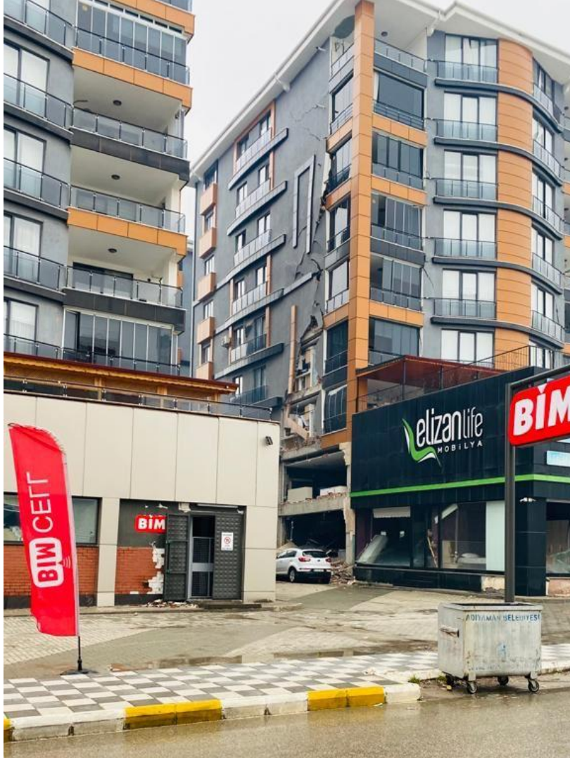
İlk Deprem Sonrası - Pazarcık (Mw=7.7)
