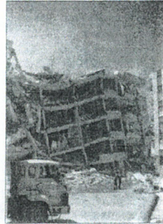
Şekil 3. Ceyhan'da Yıkılmış yapıdan bir görünüş
