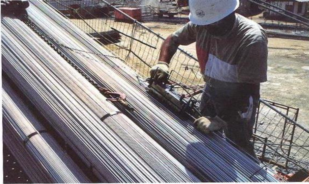
Strand catcher Telin, büküm içindeki konumuna yerleştirilmesi
