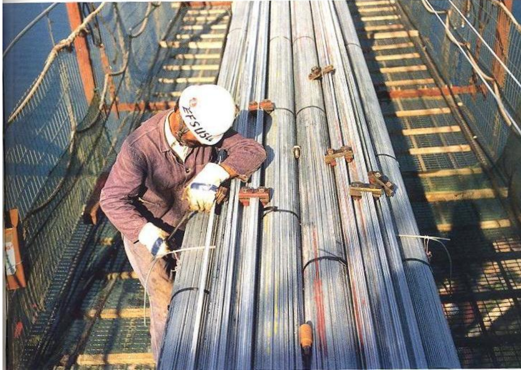
Strand catcher Telin, büküm içindeki konumuna yerleştirilmesi
