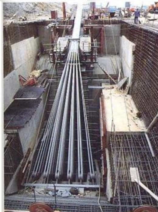
Final reeling: Cable arrives from the Asian side to the European side Son telin çekilmesi: Kablo tamamlanıyor
