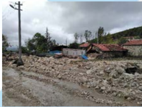
Şekil 11. Mahalle içinde yıkılan ev
