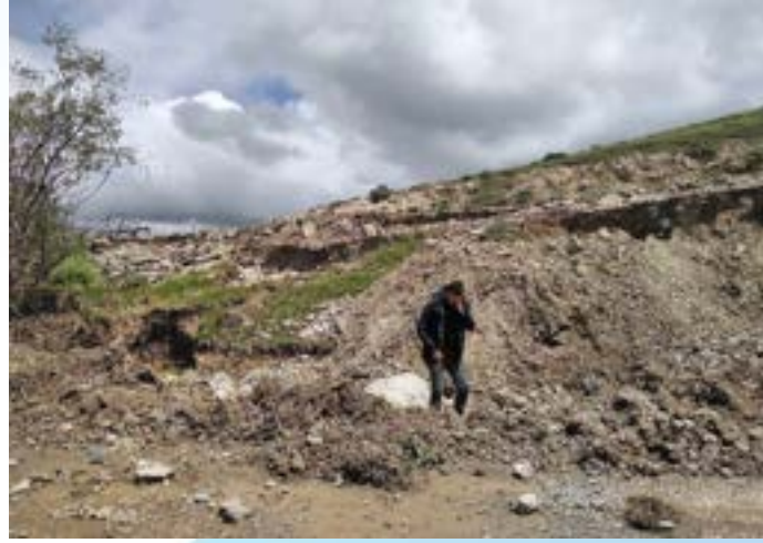
Şekil 4. Sulama Kanal Şevi
