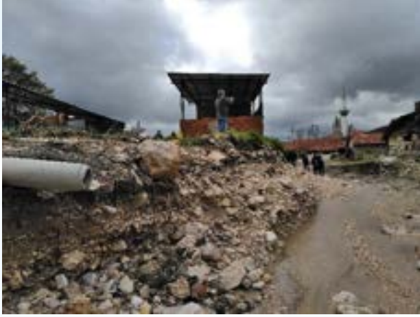
Şekil 9. Çatören mahallesi köyiçi yolu
