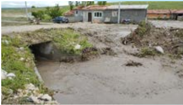
Şekil 14. 2x2 boyutlarındaki menfez kesiti
