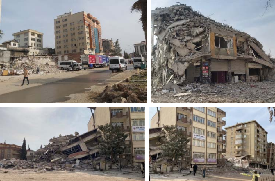
Trabzon Bulvarında yolun bir tarafında enkaz haline dönüşmüş binalar, diğer tarafında ise yönetmeliğe uygun inşa edilmiş ve ayakta kalmış binalar görülmekte.
