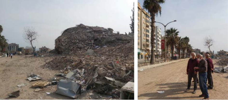
Trabzon Bulvarında yolun bir tarafında enkaz haline dönüşmüş binalar, diğer tarafında ise yönetmeliğe uygun inşa edilmiş ve ayakta kalmış binalar görülmekte.
