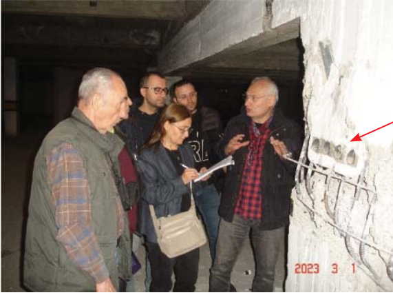
Kolon üzerinde sonradan açılan çok sayıda elektrik buat delikleri nedeniyle kesit zayıflatılmış
