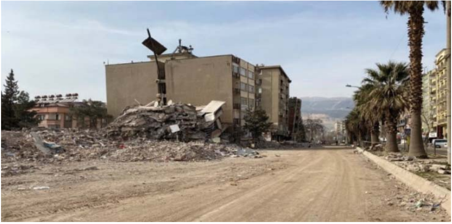
Trabzon Bulvarında yolun bir tarafında enkaz haline dönüşmüş binalar, diğer tarafında ise yönetmeliğe uygun inşa edilmiş ve ayakta kalmış binalar görülmekte.
