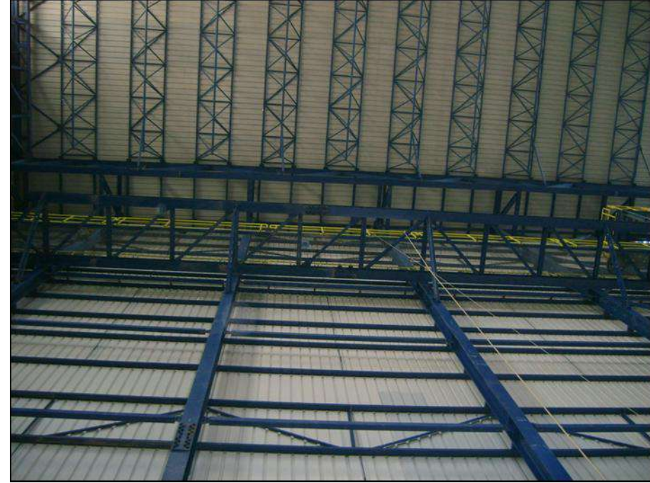
12 m. AÇIKLIK GEÇEN BORU UZAY AŞIKLARIN GÖRÜNÜŞÜ
