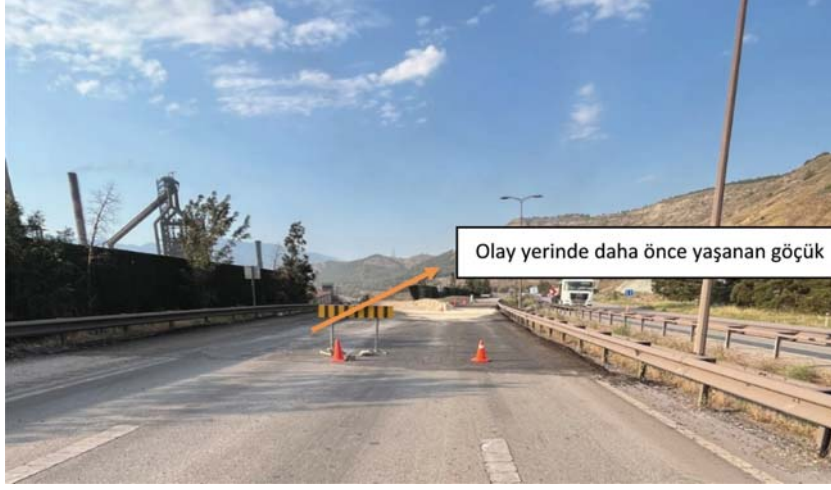
Fotoğraf 5 - Göçmenin yaşandığı bölgedeki yüzeysel tamiratlar
