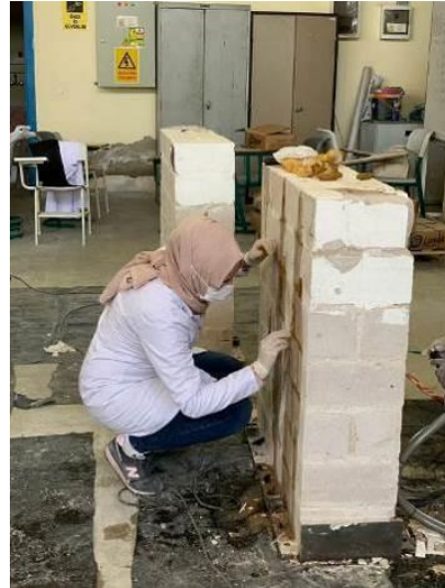
Duvar boşluklarının macunlanması
