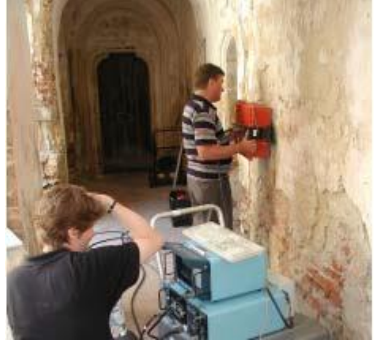
Radar (GPR) uygulaması (Diamanti vd., 2008).
