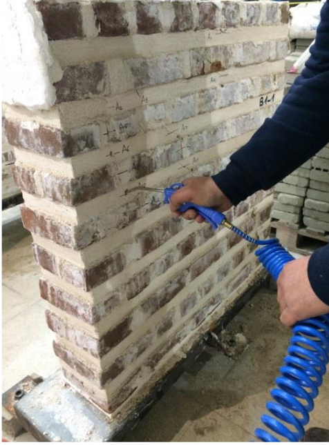
Hava ile boşlukların temizlenmesi
