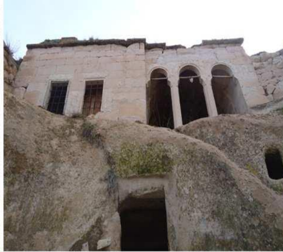
Kaya Oyma ve Yığma Yapı
