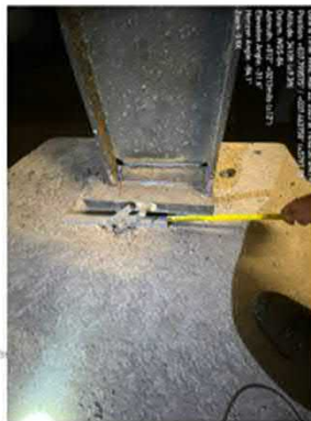
Boru desteklerindeki artık yer değişimleri
