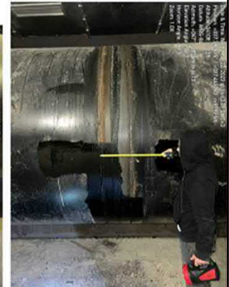
Tünelin ortasına 30 cm'lik bir ekleme kaynaklandı
