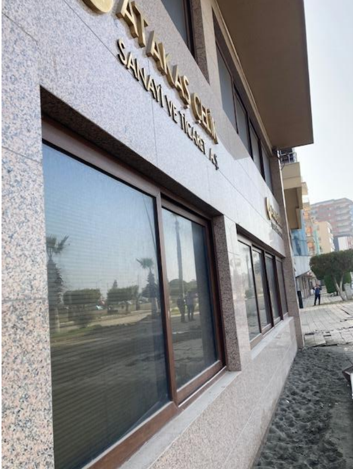
Çay Mahallesi'nde sıvılaşma kaynaklı taşıma gücü problemleri ve oturmalar (Resim: Pelin Özener)
