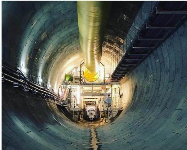
Resim : Doha Metrosu/Gülermak ÇTD precast segment uygulaması, 2017
