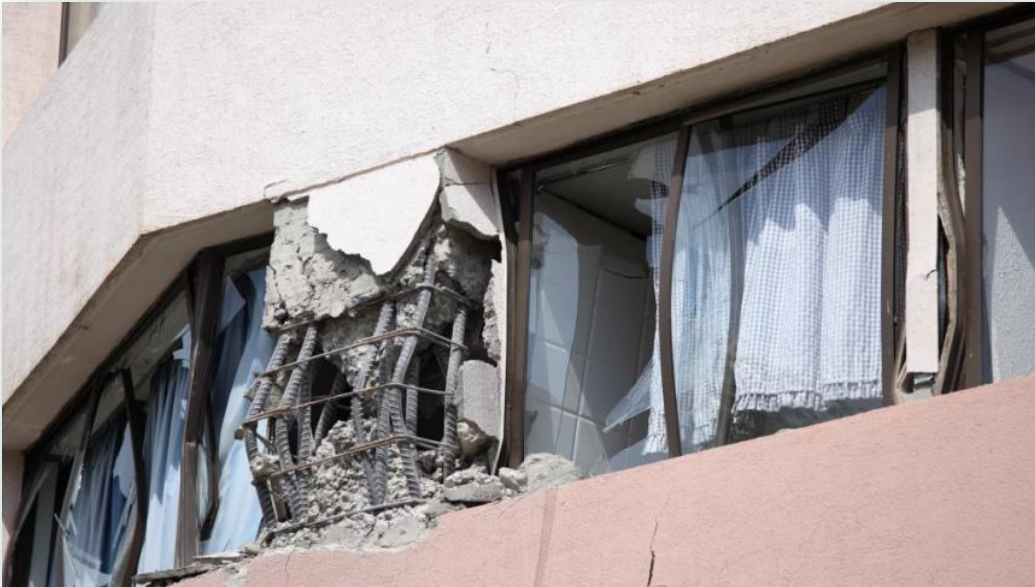
Fotoğraf 7- Kısa Kolon Davranışı Nedeniyle Hasar Gören Kolonlar
