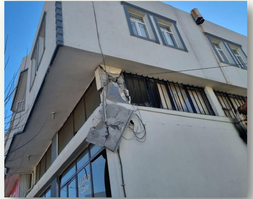
Fotoğraf 7- Kısa Kolon Davranışı Nedeniyle Hasar Gören Kolonlar
