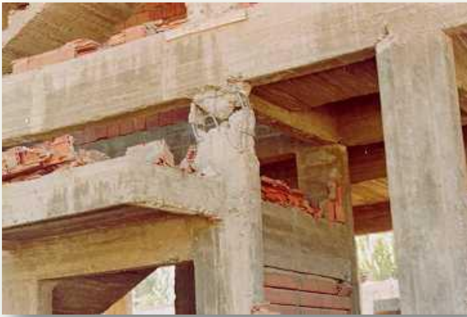
Fotoğraf 7- Kısa Kolon Davranışı Nedeniyle Hasar Gören Kolonlar
