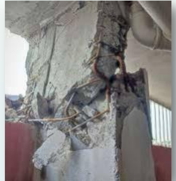
Fotoğraf 7- Kısa Kolon Davranışı Nedeniyle Hasar Gören Kolonlar
