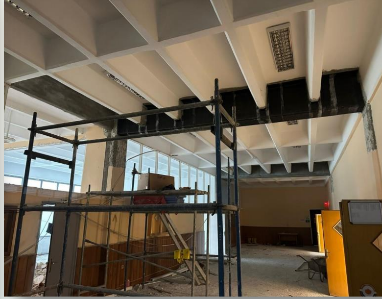
Fotoğraf 6- LP ile Betonarme Kiriş Güçlendirilmesi
