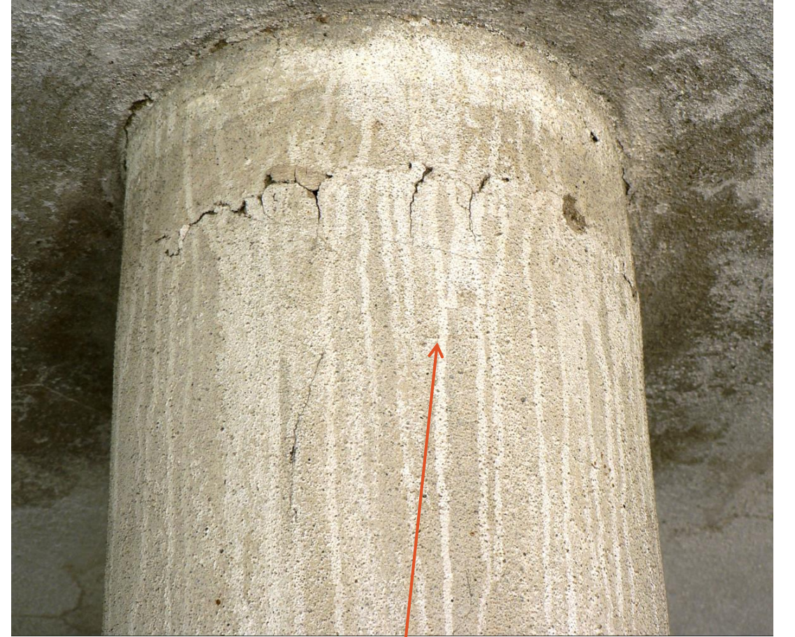
Kolon Basınç Ezilmesi
