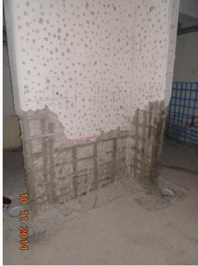
Korozyon Onarımı Temizlik -Korozyon önleyici- epoksi, aderans artırıcı – Yapısal tamir harcı
