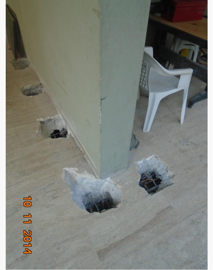
Kendinden yerleşen beton
