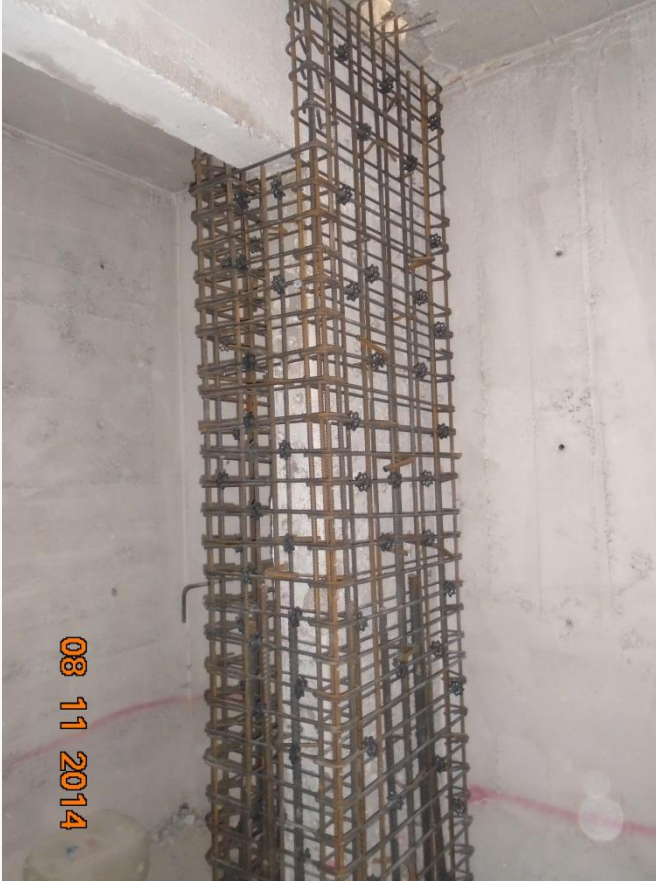
Donatı – Mevcut Betona Ankraj
