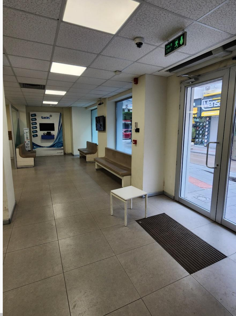
Güçlendirilmiş Yapı – Deprem Sonrası
