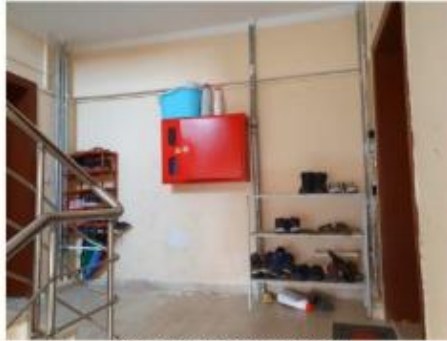
GÜÇLENDİRİLMİŞ Lojman Merdiven Hali
