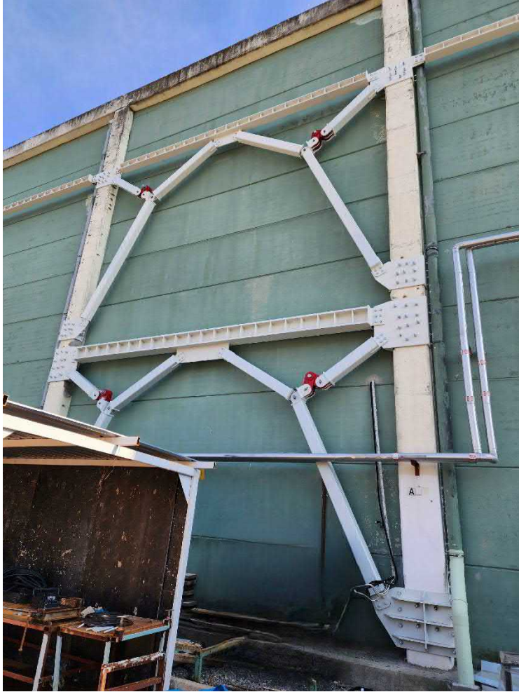
Betonarme Prefabrik Yapı Sönümleyici Kullanarak Güçlendirme - Montaj Sonrası
