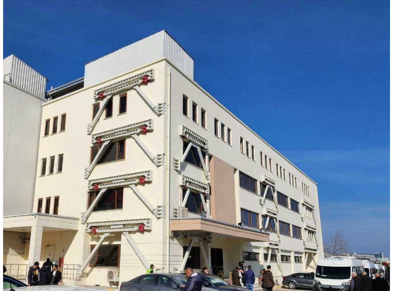
İdari Yapı Sönümleyici Kullanarak Güçlendirme - Montaj Sonrası
