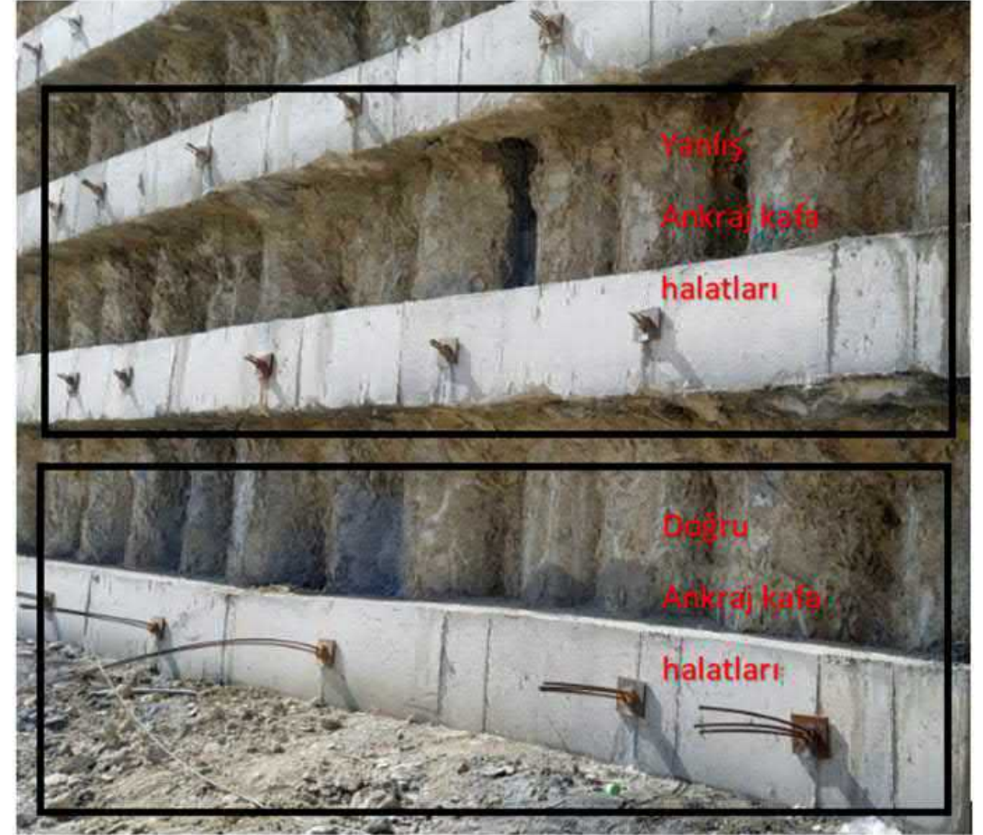
Resim 3.7. Ankraj halatları doğru ve yanlış aynı karede
