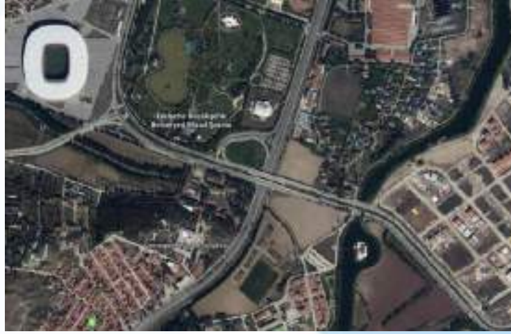
Uydu Görüntüsü-4: Mevcut Sazova Karayolu Köprülü Kavşağı
