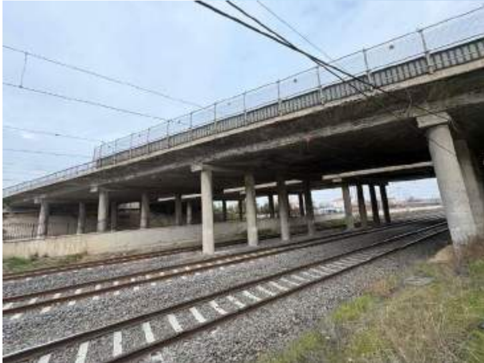
Fotoğraf-1: Şeker – Fevziçakmak Mahallesiinde Bulunan Demiryolu Üstündeki KGM Köprüsü
