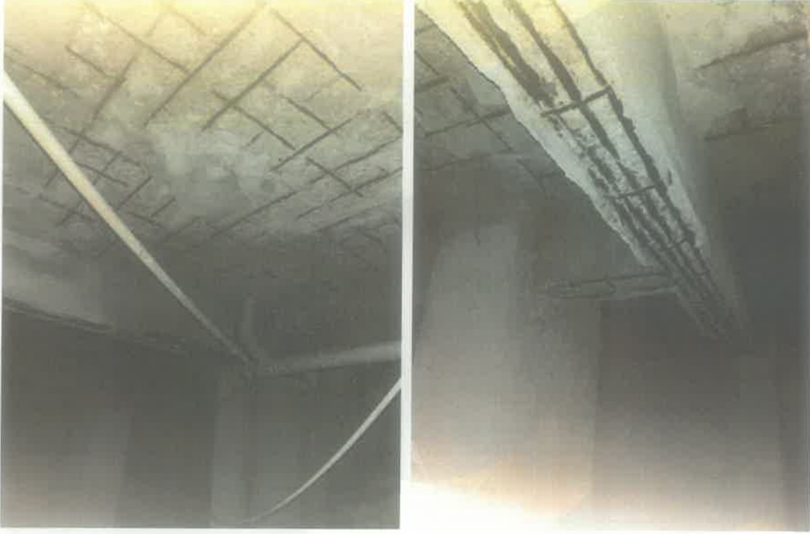
Fotoğraf 10. Betonarme giriş ve döşemede korozyon hasarı örnekleri
