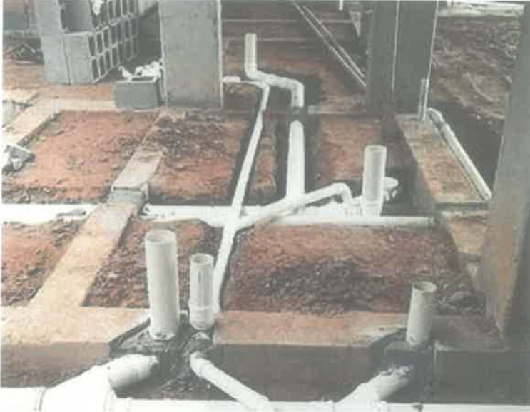
Fotoğraf 6. Temelde ve kolonda tesisat geçişleri ile verilen hasar
