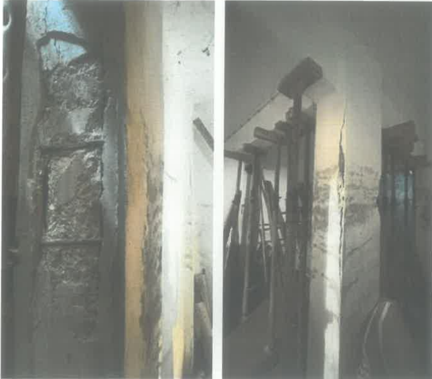
Fotoğraf 10. Betonarme giriş ve döşemede korozyon hasarı örnekleri
