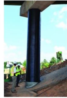
Kolonları CFRP Mantolama
