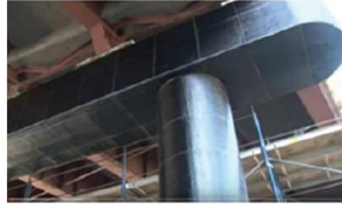
Başlık Kirişini CFRP İle Güçlendirme
