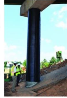
Kolonları CFRP Mantolama
