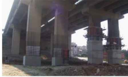
Kolonları Betonarme Mantolama
