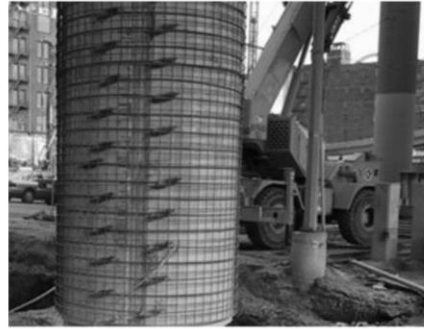
Germeli Tendonlar Sarma ve Betonarme İle Mantolama Yaparak Kolon Güçlendirme.
