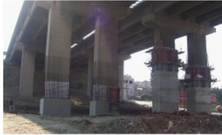
Kolonları Betonarme Mantolama
