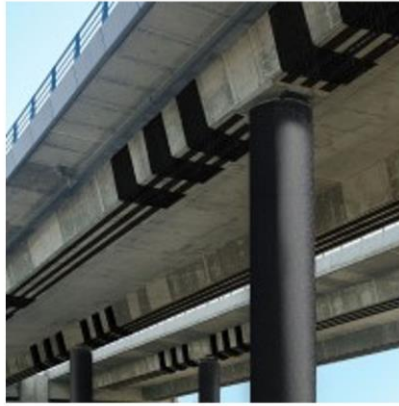
Döşemenin CFRP İle Kesmeye ve Eğilmeye Karşı Güçlendirilmesi
