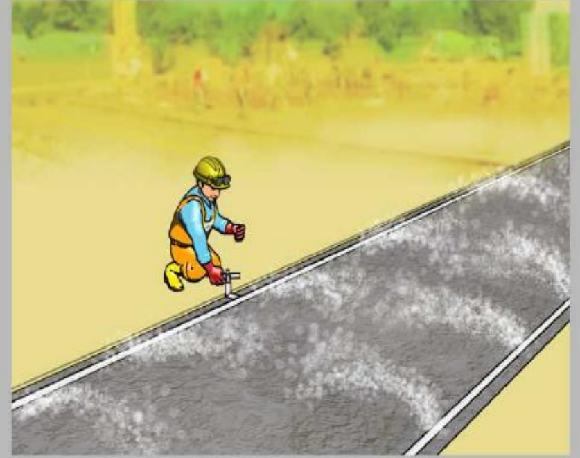
Resim12: Betonyüzeyindepüskürtme sis. oluşturulması
