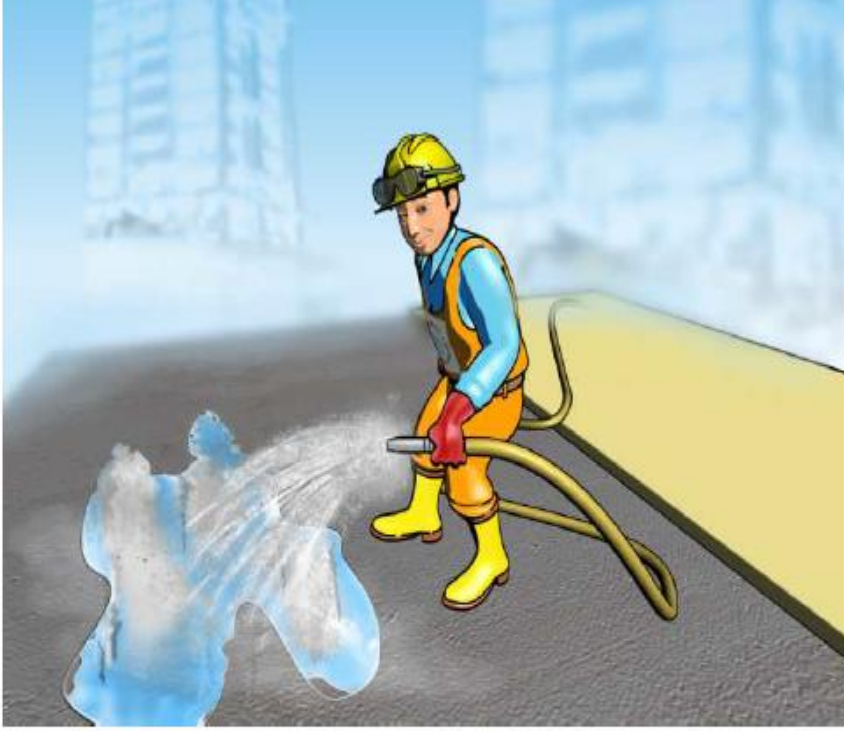
Resim 11: Beton yüzeyinin hortumla sulanması
