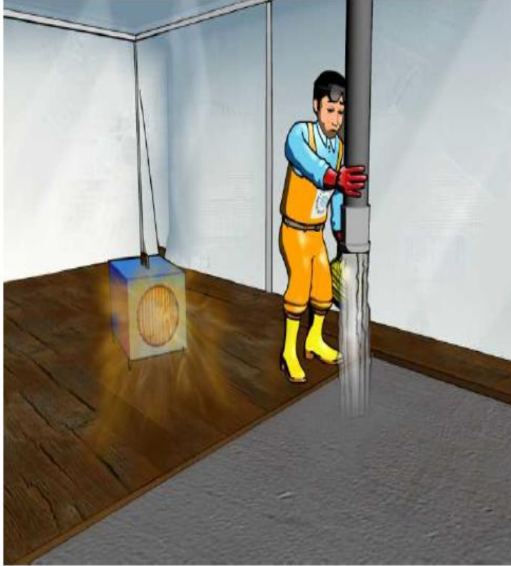
Resim 16: Soğuk havada beton sıcaklığı sürekli kontrol edilmelidir.
