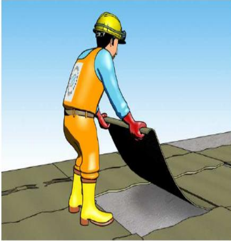
Resim 13: Beton yüzeyine telis bezi serilmesi
