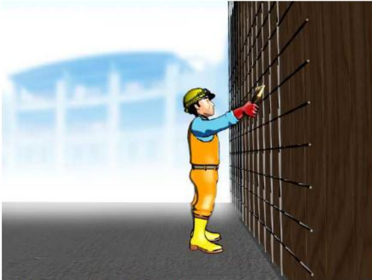
Resim 1: Kalıpların yağlanması
