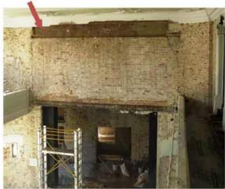
Resim 79. 2.Kat Sahne Düzarında Yer Alan Mevcut İPN 550 Hatı
