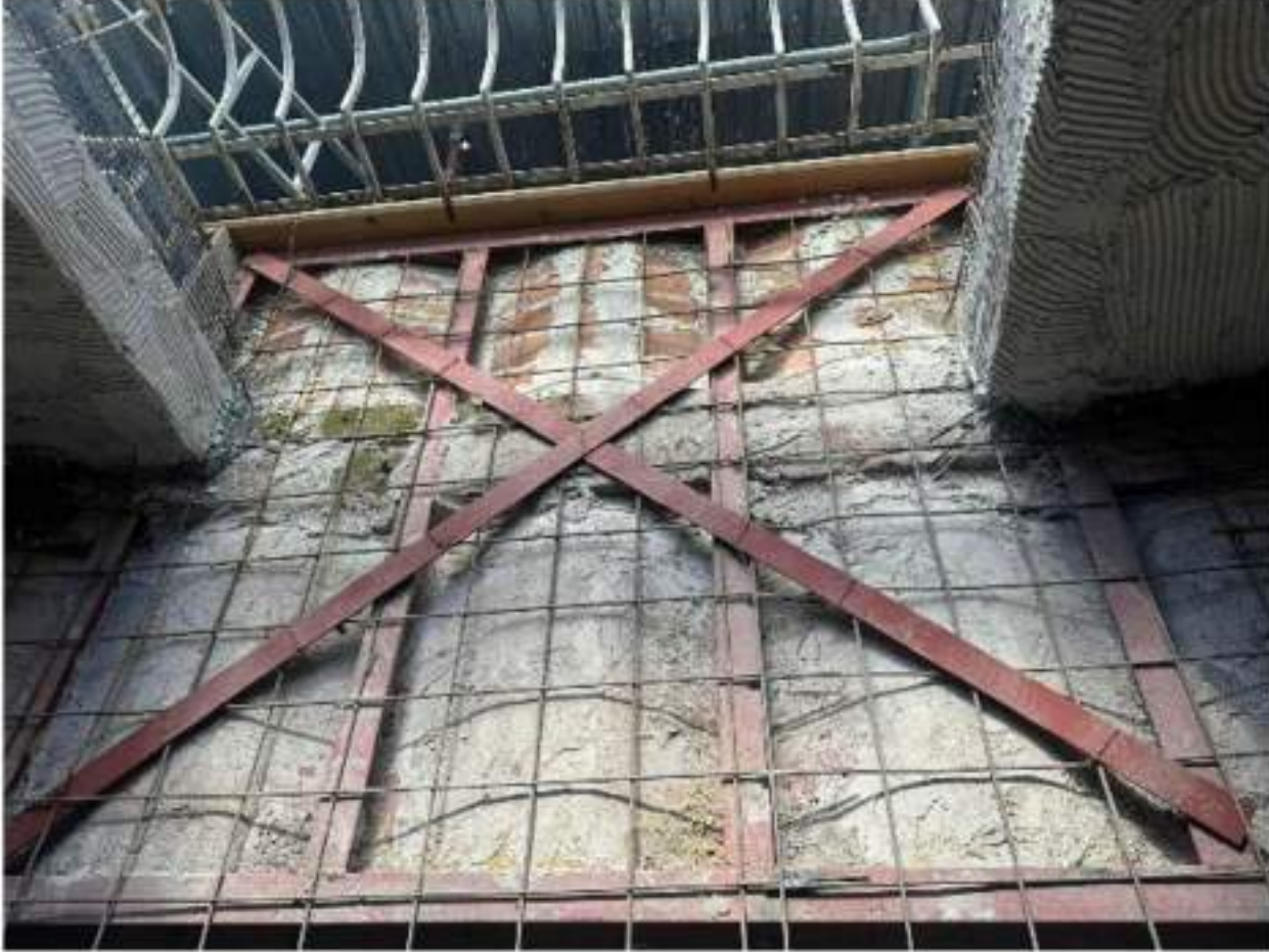
Monolitik davranış için eklenen çapraz çelik levhalar ve mesnetlenme detayı
