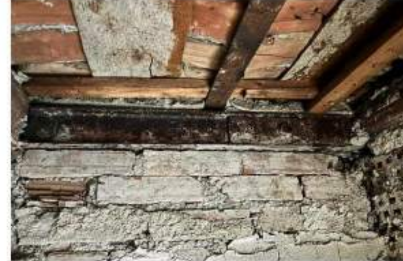
Yığma duvar üstündeki hatıla mesnetlenen I profil
