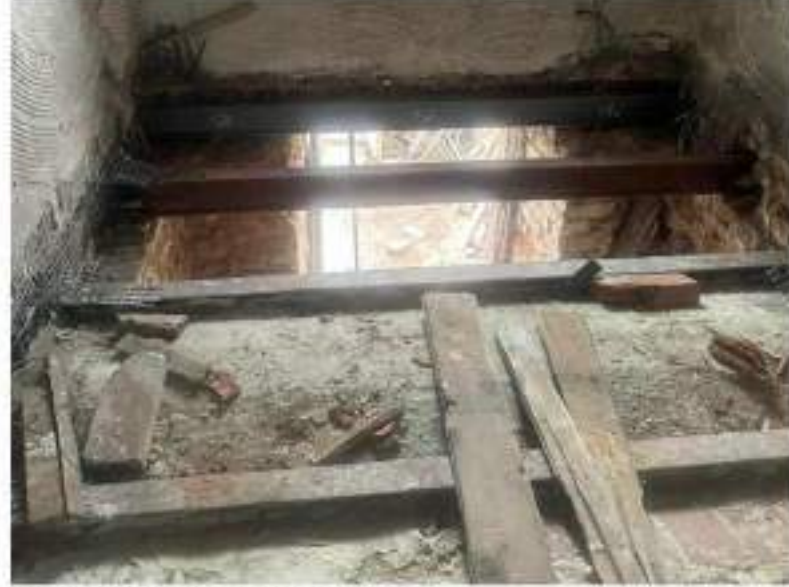
Yığma duvar üstüne serbest outran I profil
