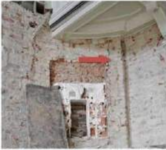
Resim 75. 1.Kat 02 Nolu Oda Yan Cephe (Alman İlkokuluna Bitişik) Sahne Duvarındaki Mevcut Çatlak
