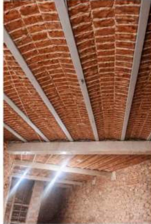
Mevcut çelik profillere korozyona karşı koruma boyası uygulaması
