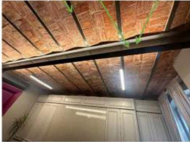
Döşemeye çelik profillerle takviye yapılması
