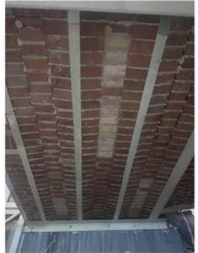
Mevcut çelik profillere korozyona karşı koruma boyası uygulaması
