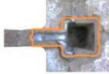
3. Simit ve Kurşun Dolgu: Ankrajın duvara sabitlendiği yuva.
