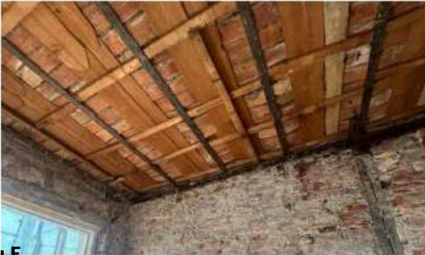
Yığma duvar üstündeki hatıla mesnetlenen I profil
