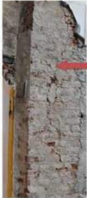
Resim 73. 2.Kat 07 Nolu Ana Merdiven Yan Cephe (Alman İlkokuluna Bitişik) Duvarındaki Mevcut Çatlak
