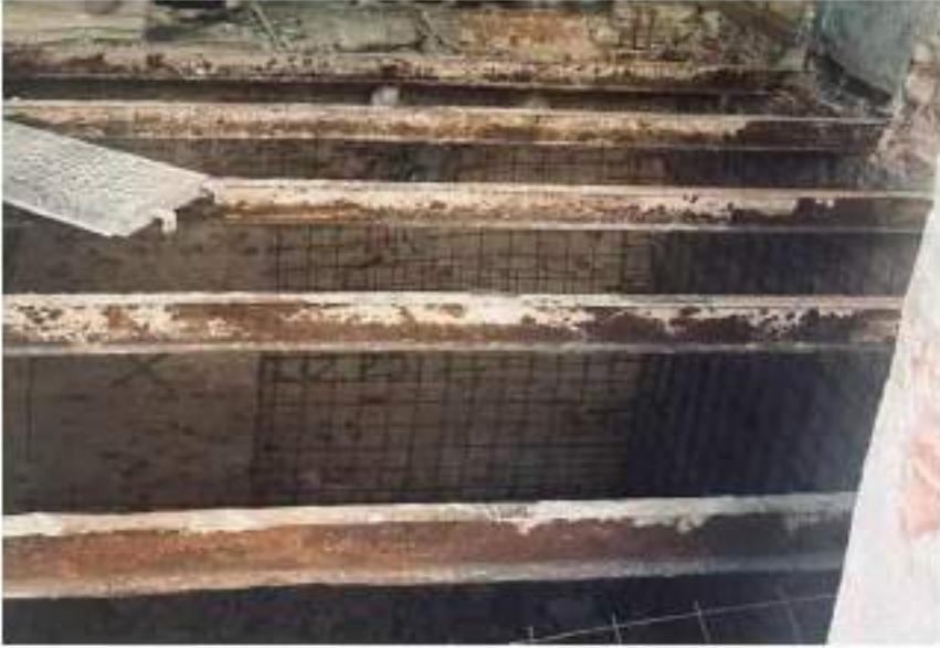
Yığma duvar üstüne serbest outran I profil
