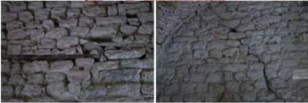
Şekil 84. B Duvar Yüzü, D Duvar Yüzü
