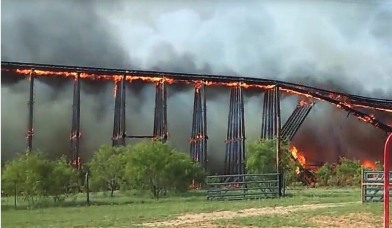
Yangın nedeniyle Trestle köprüsünün göçmesi (Lampasas County, TX, USA, 2013).
