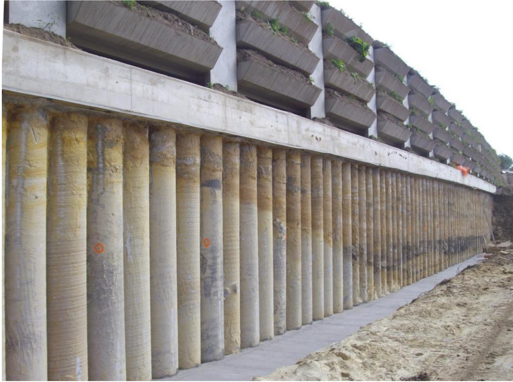
Şekil. Konsol Fore Kazıklı Duvarlar
