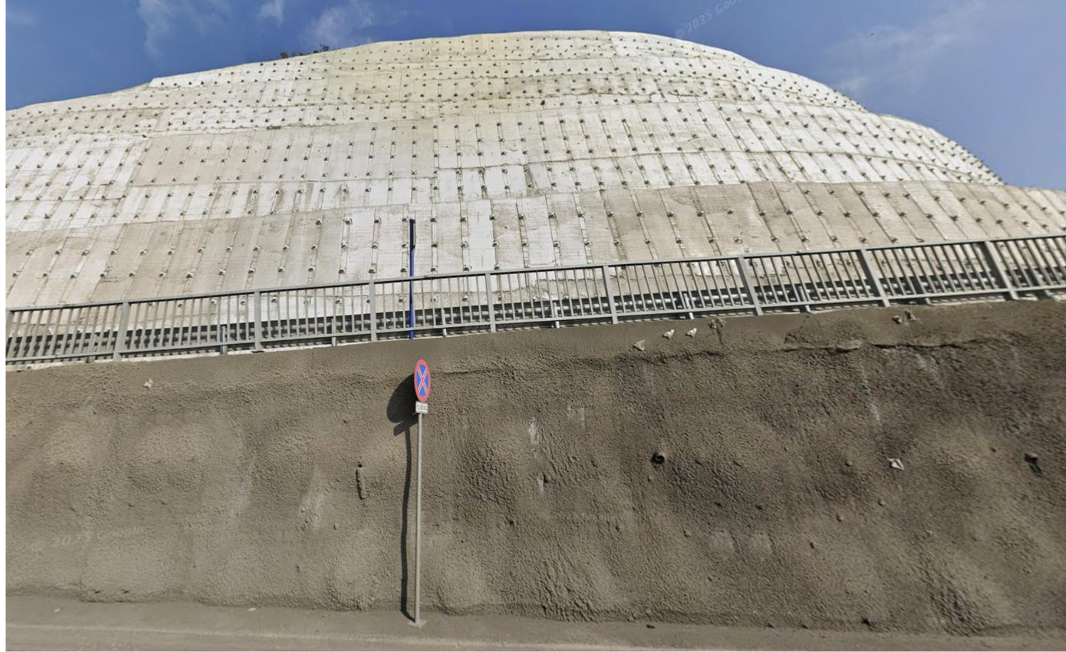
Şekil. Gebze Yılport - Çolakoğlu Ulaşım Yolu 48 m Kalıcı İksa Yapısı
