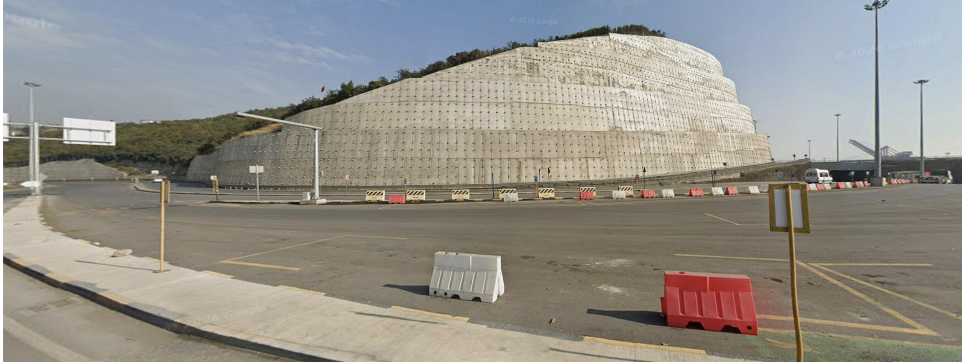
Şekil. Gebze Yılport - Çolakoğlu Ulaşım Yolu 48 m Kalıcı İksa Yapısı
