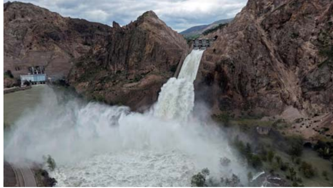
Fotoğraf 2 - Kılıçkaya Barajı dolusavak yapısından suyun deşarjı
