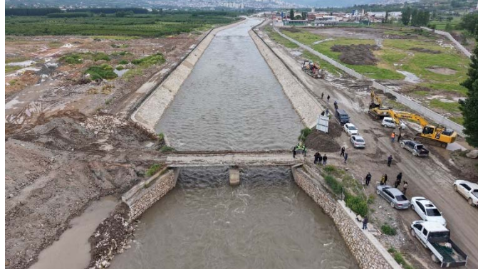
Fotoğraf 4- Yenisanayi Köprüsü'nün yıkımı
