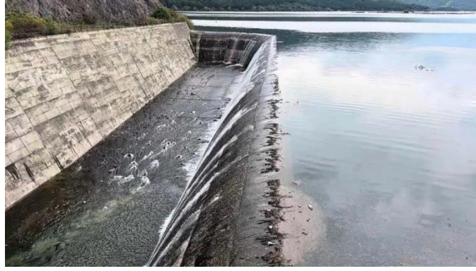
Fotoğraf 1 - Almus barajı kontrolsüz dolusavak yapısı
