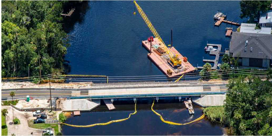
LP donatılar kullanılarak inşa edilen Halls River Köprüsü (Florida)
