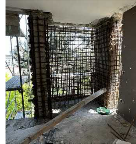
Betonarme perde ilavesi
