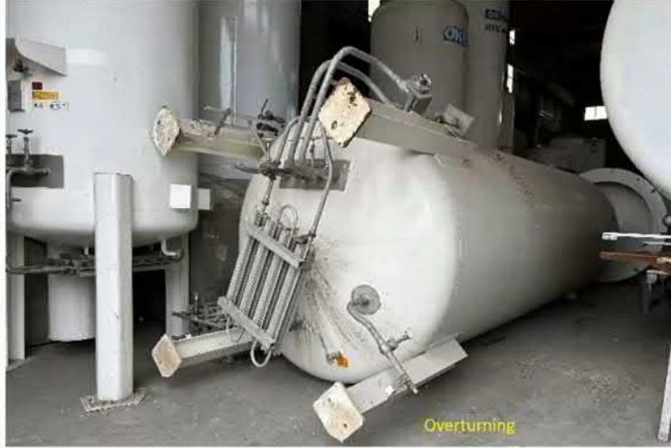
Ankrajlanmamış LPG tankının devrilmesi
