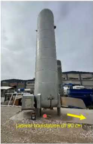
Ankrajlanmamış LPG tankının devrilmesi
