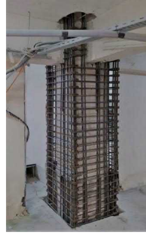
Betonarme mantolama
