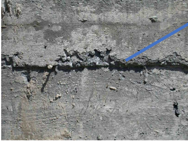
Kalıp Hatası
