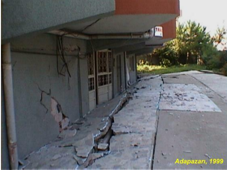
Sivilaşmaya Bağlı Aşırı Oturma
