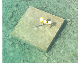
Tekneyi kıçtan bağlamak için tonozla bağlı mapa
