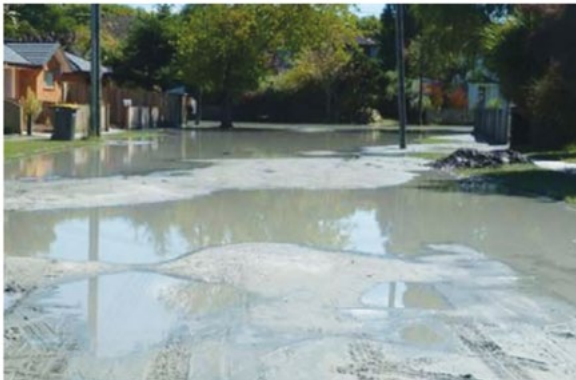
Şekil 2. Christchurch şehri içinden sivilaşma örnekleri (Van Ballegooy ve diğ., 2014)
