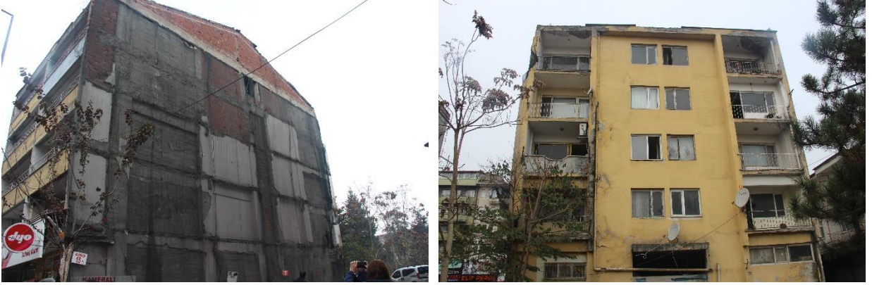
Şekil 14: Güçlendirilmiş binaların Gölyaka depremi sonrası durumları
