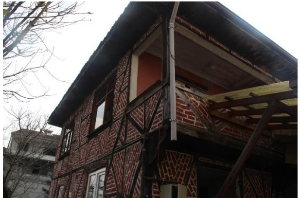
Şekil 13: Hasarsız hımmiş bina örnekleri
