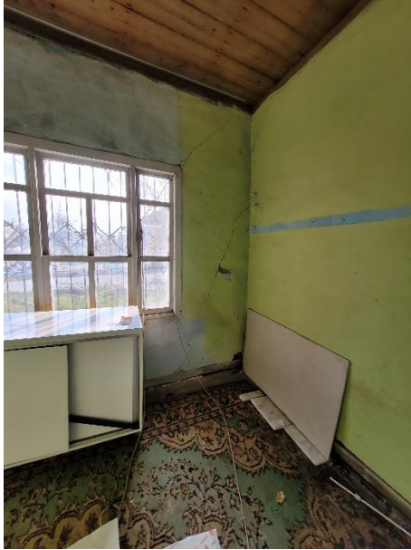
Şekil 12: Yığma binalarda yapısal hasar örnekleri (devam)
