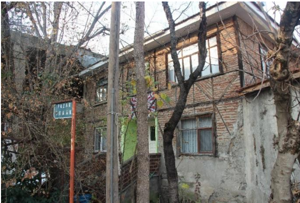
Şekil 13: Hasarsız hımmiş bina örnekleri
