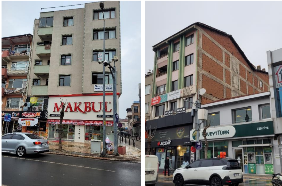
Şekil 14: Güçlendirilmiş binaların Gölyaka depremi sonrası durumları
