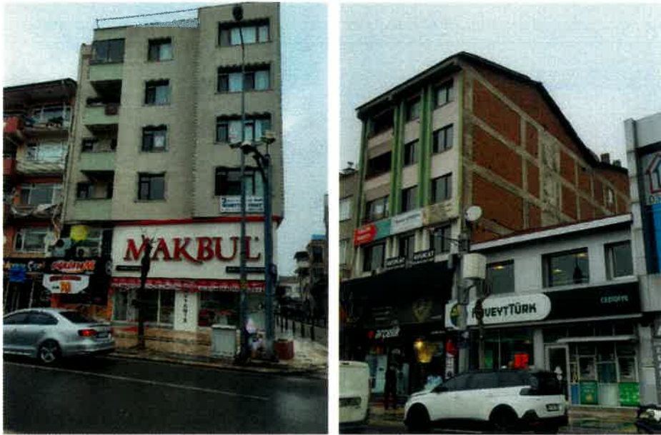
Şekil 14: Güçlendirilmiş binaların Gölyaka depremi sonrası durumları
