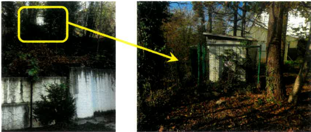
Şekil 6: 8105 kodlu kayıt istasyonunun görünüşü
