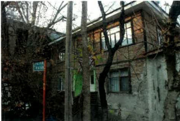
Şekil 13: Hasarsız hımış bina örnekleri
