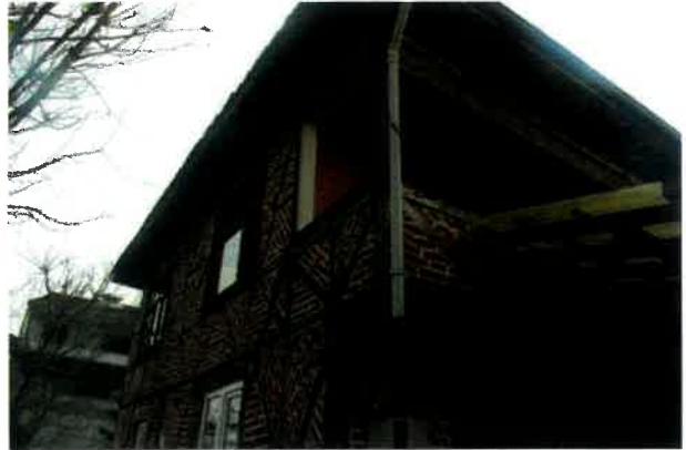
Şekil 13: Hasarsız hımış bina örnekleri
