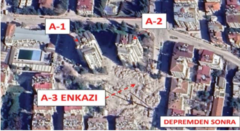
Fotoğraf 18 - Antakya Belediye Bloklarının 6 Şubat 2023 Depremi sonrası görünüşü (Fotoğraflar İnşaat Mühendisi Ali Hoca'dan alınmıştır).
