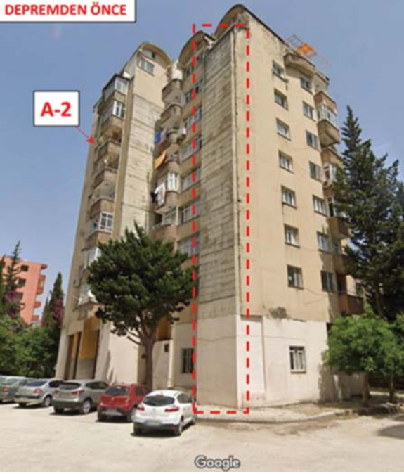
Fotoğraf 16 - Perde duvarla güçlendirilmiş yapı
