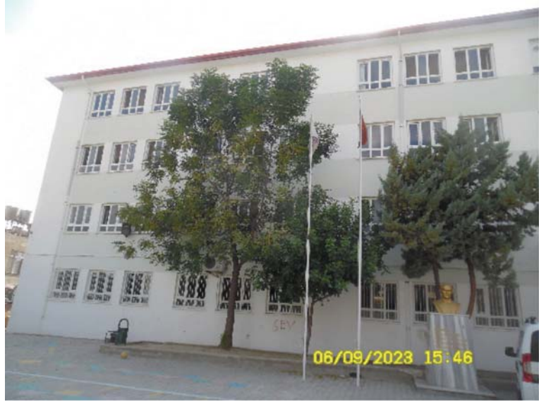
Fotoğraf 19 - Antakya'da 6 Şubat 2023 Depreminde en ufak çatlak bile olmayan Okul yapısı (Antakya Samandağ Şehit Teğmen Ali Emre Fırıncıoğulları Okulu). Millî Eğitim Bakanlığının Tip projesine göre yapılmış okul. Yapıda her iki yönde ve yapı köşelerinde L-perde duvarlar vardır.
