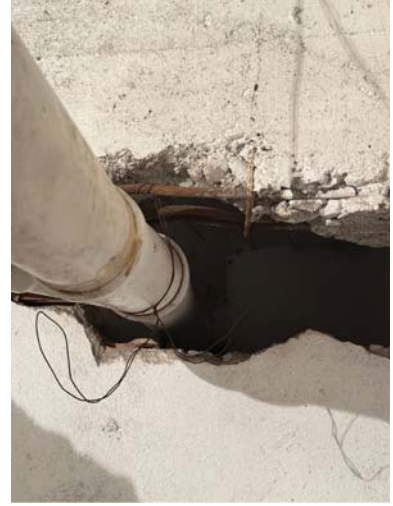
Fotoğraf 3 - Betonarme kirişte boru geçişi ile verilen hasar
