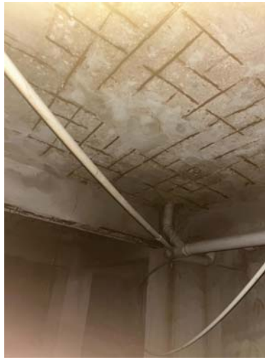
Fotoğraf 10 - Betonarme kiriş ve döşemede korozyon hasarı örnekleri
