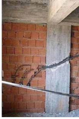
Fotoğraf 6 - Temelde ve kolonda tesisat geçişleri ile verilen hasar
