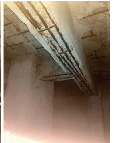
Fotoğraf 10 - Betonarme kiriş ve döşemede korozyon hasarı örnekleri
