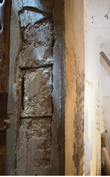
Fotoğraf 11 - Betonarme kolonlarda ve döşemede korozyon hasarı örnekleri
