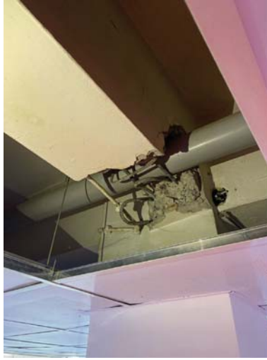
Fotoğraf 8 - Betonarme kirişte tesisat geçişleri ile verilen hasar
