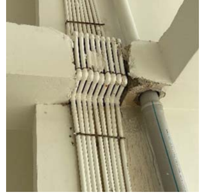
Fotoğraf 7 - Betonarme kirişte tesisat geçişleri ile verilen hasar
