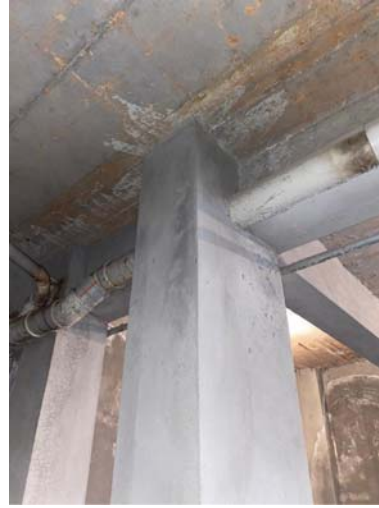
Fotoğraf 9 - Betonarme kolonda tesisat geçişleri ile verilen hasar
