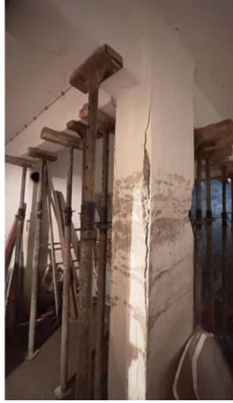
Fotoğraf 11 - Betonarme kolonlarda ve döşemede korozyon hasarı örnekleri
