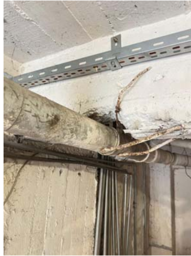
Fotoğraf 4 - Betonarme kiriş gövdesinde boru geçişi için kiriş ve donatıya verilen hasar
